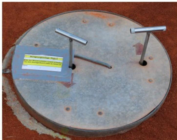
Die Beregnungsanlage für die Plätze 1-3 wird nach jeweils 5 Minuten automatisch abgeschaltet, kann aber durch nochmaliges Drücken des Schaltknopfes auch situationsangepasst gesteuert werden. Die Beregnungsanlagen der Plätze 4-6 können nur „von Hand“ bedient werden und bedingen deshalb einer „Anwesenheitspflicht“ während des Bewässerns. Die Absperrventile dieser Plätze ebenfalls wie die der Schläuche bitte immer fest zudrehen!
